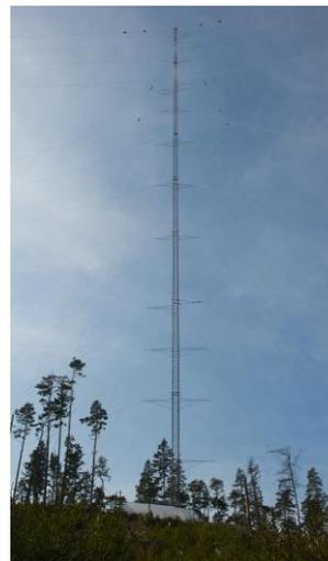
Der 200-m-Forschungsmessmast des Fraunhofer IWES bei Kassel ermöglicht es, das Windprofil bis in große Höhen genau zu bestimmen sowie neue Fernmesstechnologien wie LiDAR zu erproben und zu validieren
